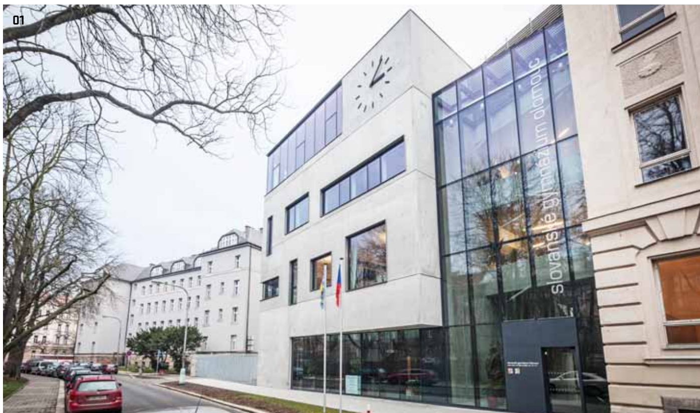
01 > Přístavba je umístěna na hraně parcely školy, nové křídlo průčelím navazuje na historickou budovu, dále se pak zalamuje podél pozemku směrem do vnitrobloku
