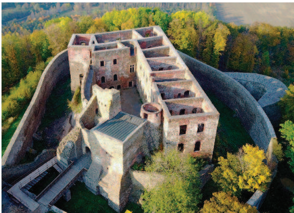
Obr. 1: Hradní palác, stav r. 2017. (Foto M. Novotný)
