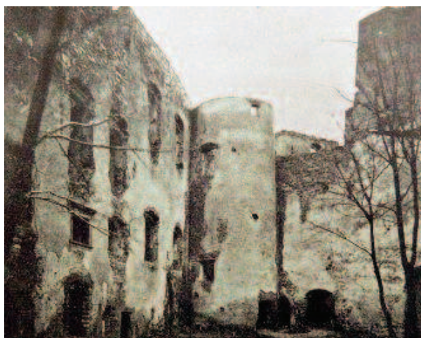
Obr. 2: Dvorní průčelí, pohled od severozápadu. Stav před r. 1914 [1].
