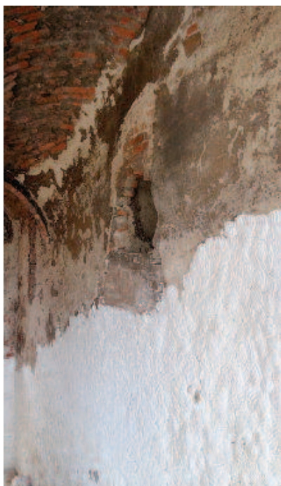
Obr. 11: Odsolování zdiva paláce pomocí buničiny r. 2019. (Foto M. Karlík)
