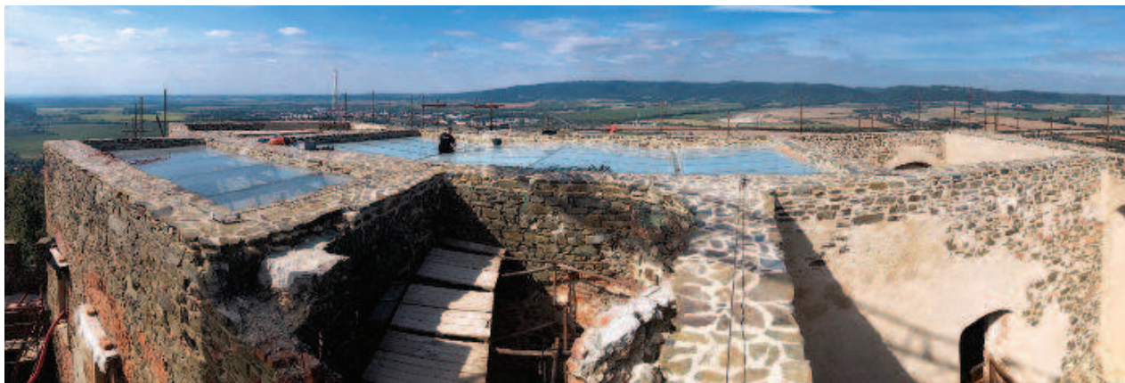
Obr. 10: Opravená koruna zdiva a nové zastřešení, stav r. 2019. (Foto M. Karlík)
