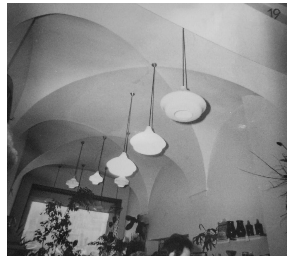
Klenutý strop bočního sálu (provozovna květinářství)
