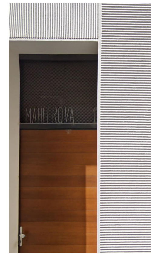
omítka hlazená zubovým hladítkem
