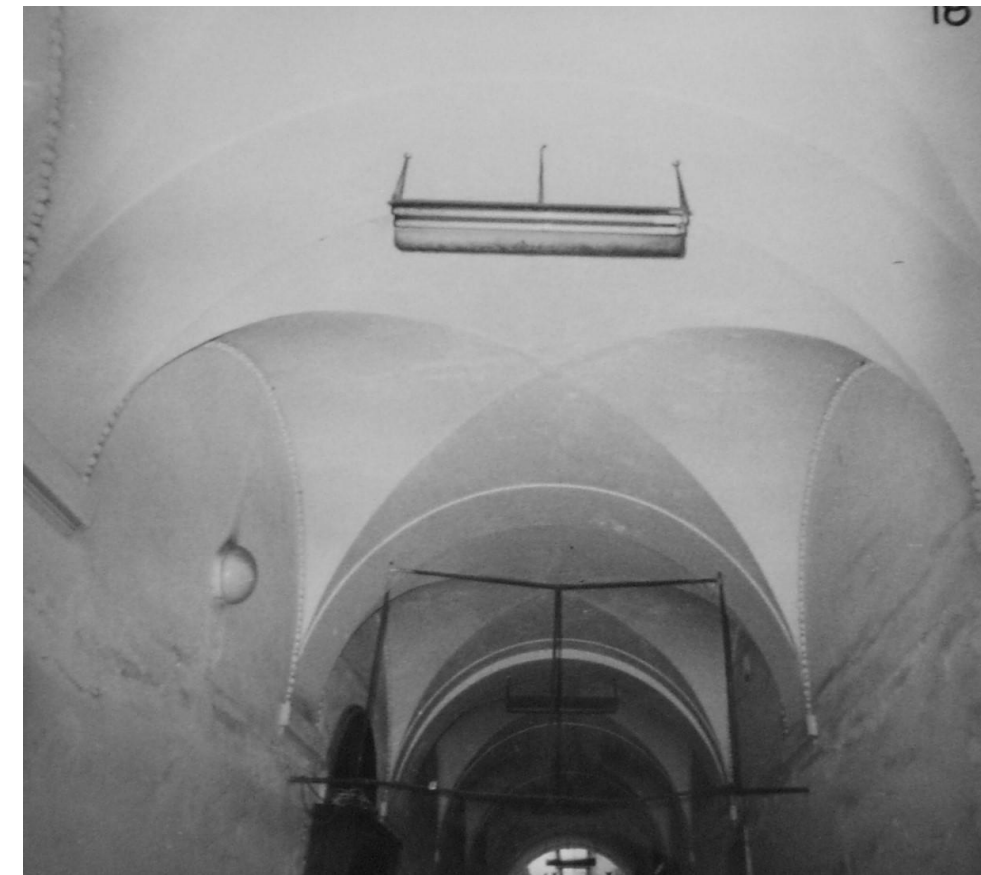
Klenutý strop průjezdu měšťanského domu
