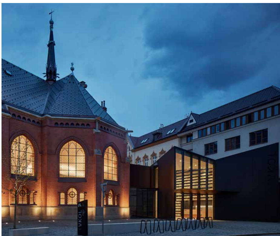
▲ Obr. 6 Nová přístavba umístěná mezi hlavní lodí kostela a objektem ředitelství knihovny vytváří společný vstupní prostor do obou objektů (foto: BoysPlayNice)
