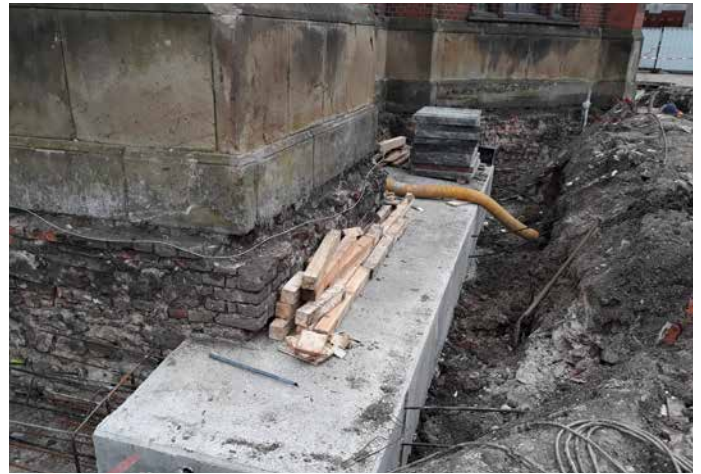
▲ Obr. 15 Zesílení stávajících základů (zdroj: OHLA ŽS, a.s., a STRABAG a.s.)
