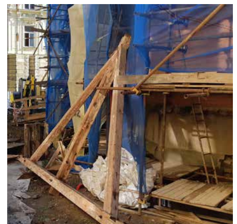
▲ Obr. 19 Postupná demontáž a průzkum prvků krovu (zdroj: OHLA ŽS, a.s., a STRABAG a.s.)
