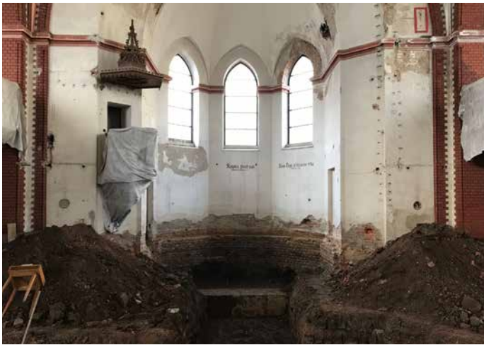
▲ Obr. 16 Hloubení podzemních kolektorů uvnitř kostela (zdroj: OHLA ŽS, a.s., a STRABAG a.s.)
