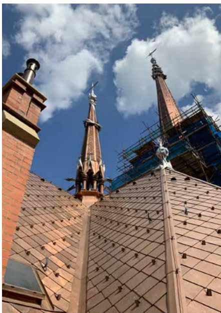
▲ Obr. 20 Měděná krytina střechy a nové kříže na věžích kostela (zdroj: OHLA ŽS, a.s., a STRABAG a.s.)
