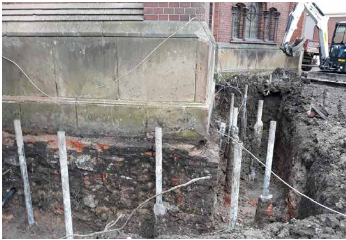
▲ Obr. 14 Statické zajištění základů kostela mikropilotami (zdroj: OHLA ŽS, a.s., a STRABAG a.s.)
